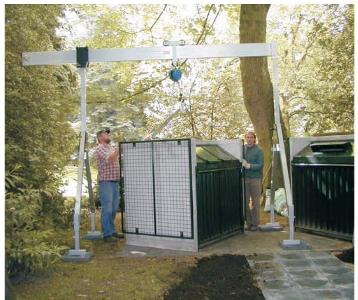
Positionieren eines Müllcontainers
