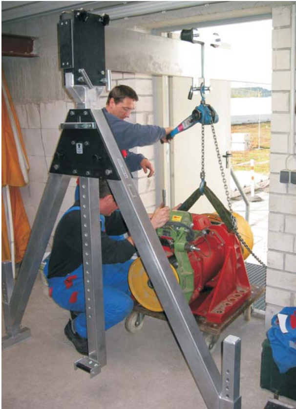
Ausbau eines Antriebmotors für Personenaufzüge
