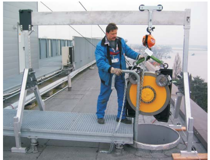
ALU-Schnellbau-Portalkran beim Versetzen eines Motors
