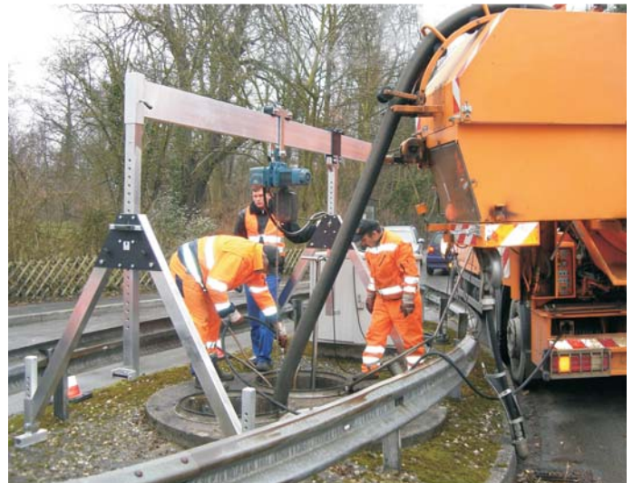
Wartungsarbeiten am Kanalisationssystem
